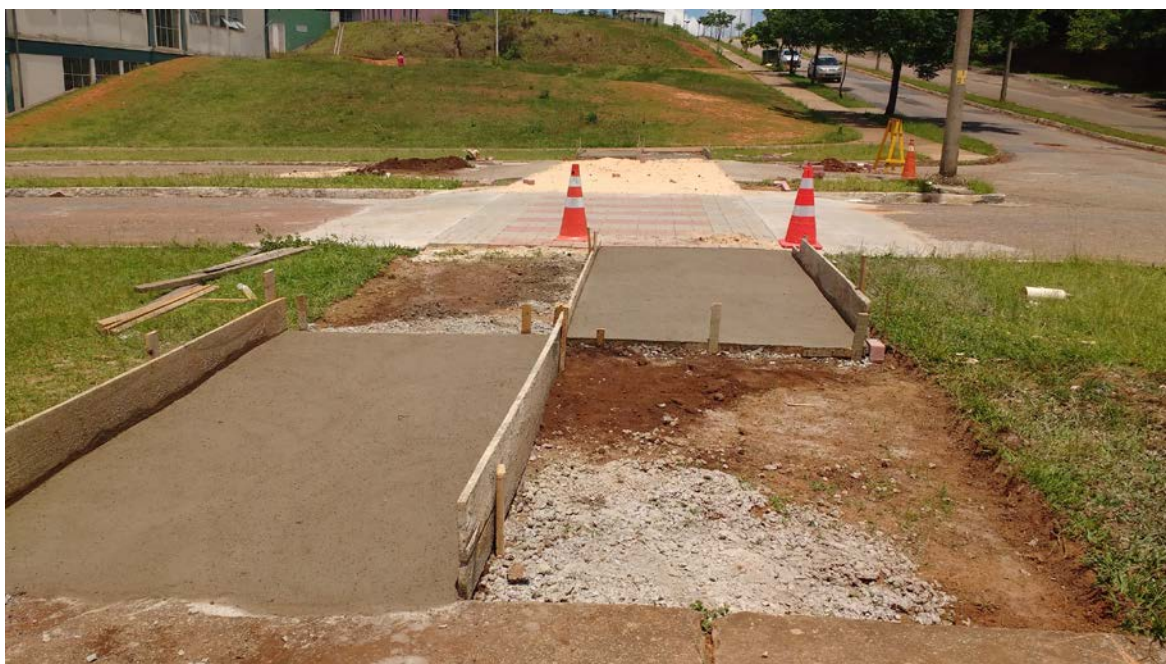
Figura 7: Construção da passarela elevada
