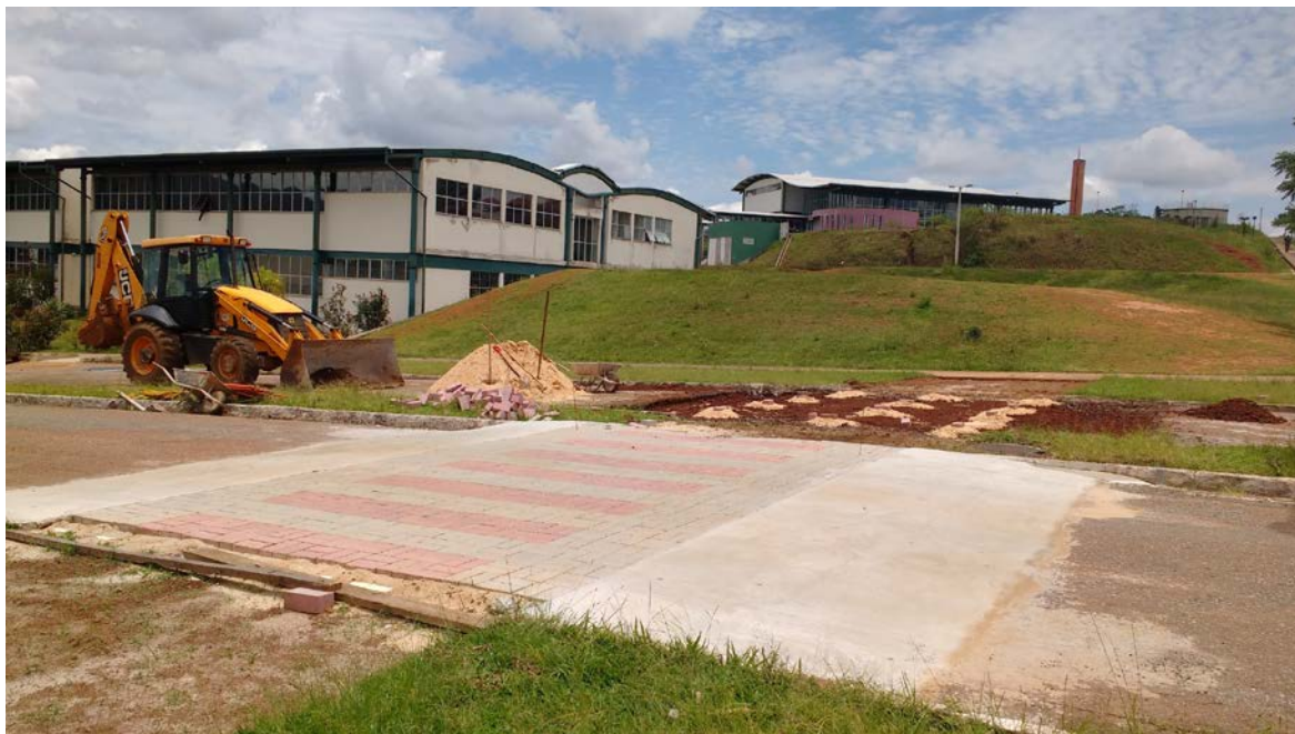
Figura 6: Construção da passarela elevada
